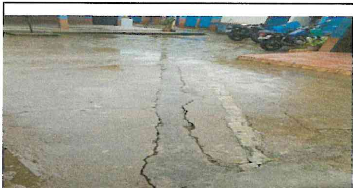
Foto 3: sustitución de torta de concreto por piso cerámico antideslizante en el area de juegos (patio)
