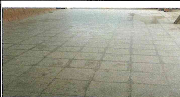
Foto 2: Sustrucción de piso de granito por piso cerámico en el corredor del aula No. 2
