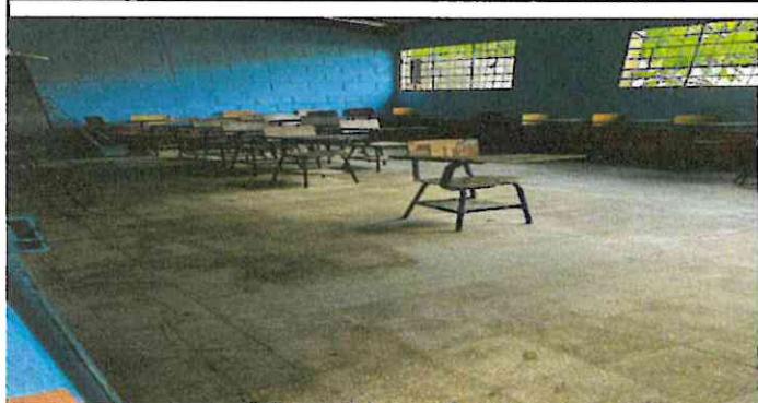
Foto 1: Sustrucción de piso de granito por piso cerámico en el aula No. 3
